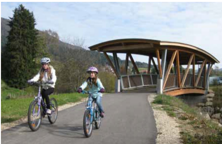
Abbildung 3: Velobrücke «Pont sur la Birse», Loveresse – Valbirse (BE)
