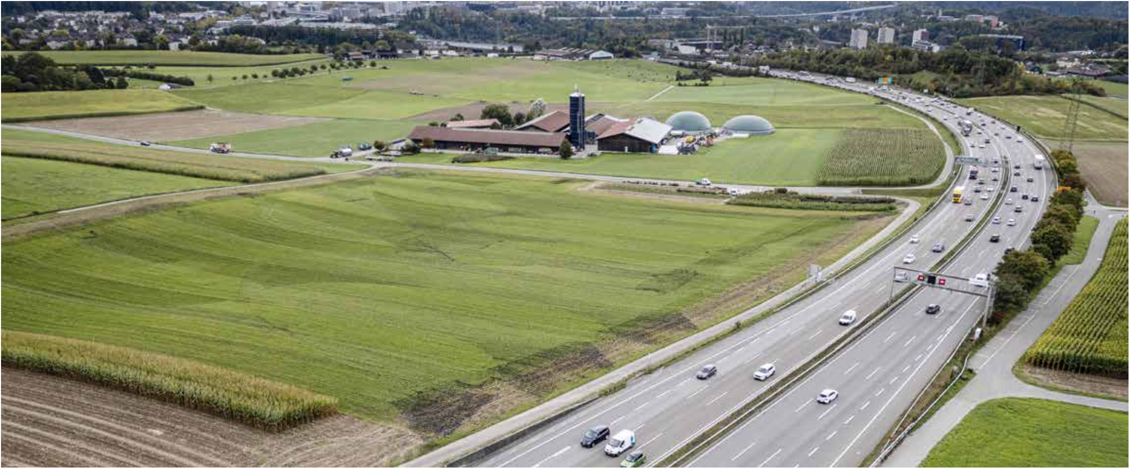
Der Abschnitt Wankdorf-Schönbühl soll auf acht Spuren erweitert werden.
