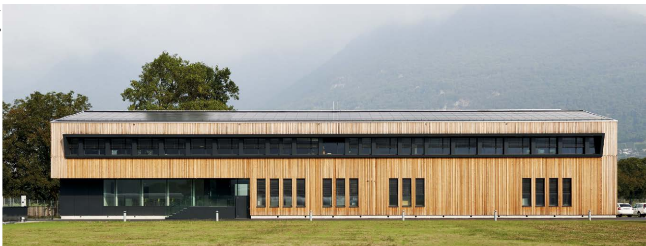
L'edificio principale del Campus di Agroscope a Cadenazzo è una costruzione in legno, conforme agli standard MINERGIE-P-ECO e MINERGIE-A-ECO.
