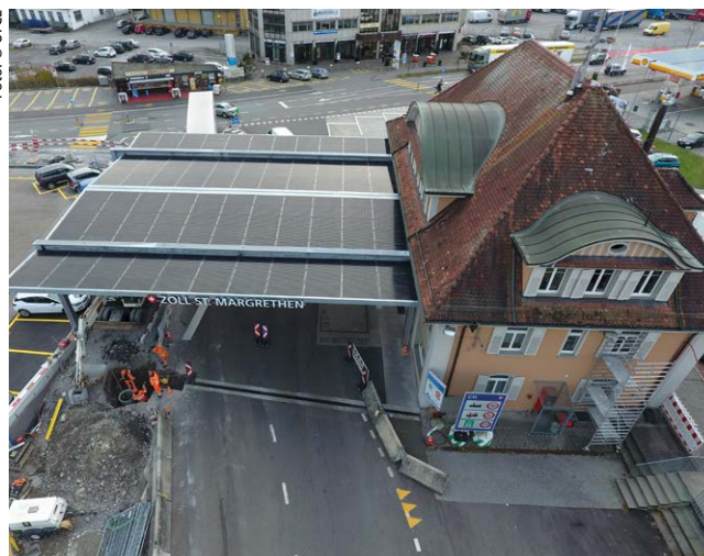
Il nuovo tetto della dogana di St. Margrethen con impianto fotovoltaico integrato.
