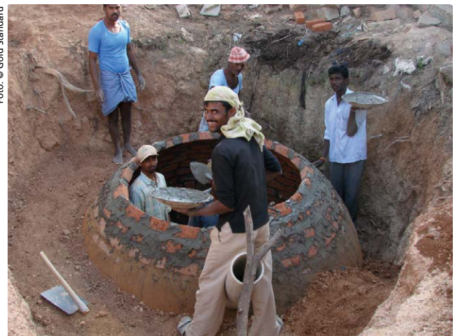
Costruzione di un piccolo impianto a biogas in uno dei progetti di compensazione selezionati.
